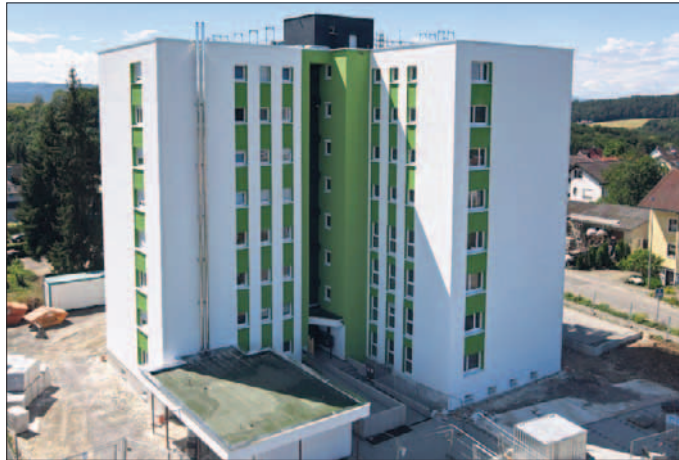
Nach der grundlegenden Sanierung stehen in der Peter-Imhoff-Straße 28 geförderte Wohnungen zur Verfügung. FOTO: KREISBAU
