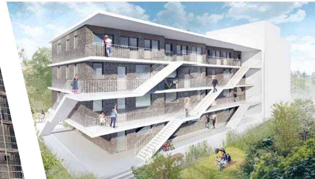
Die Architekten Max Schwitalla und Florian Danner machen das Haus zu etwas ganz Ungewöhnlichem: Die Innenschale der Fassade wird als beplankte Holzrahmenkonstruktion errichtet, die Außenfassade aus recycelten Ziegelsteinen. Hinsichtlich der Außenfassade ist vorgesehen, Geflüchtete bei den Baumaßnahmen mitwirken zu lassen, die von Baufirmen betreut werden. Zu den Wohnungen gelangt man über einen 2,50 Meter breiten Laubengang. Im Erdgeschoss der Wohnanlage entstehen Sozial- und Betätigungsräume.
