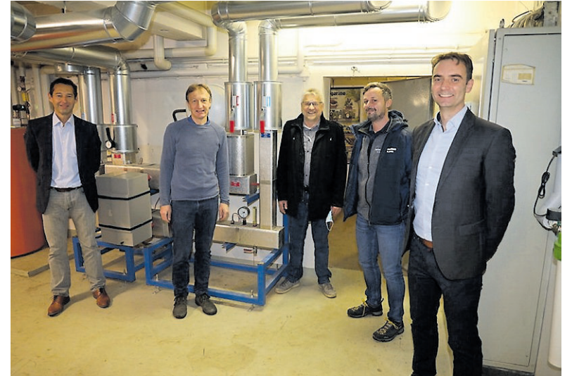
Freuen sich über das neue Netz: Justus Hoffmann (Betriebsleiter Stadtwerke Mössingen), Maruc Schumacher (Leiter Technischer Service der Stadtwerke), Tilman Lohbeck (Projektleiter beim Ingenieurbüro Ganssloser), Holger Fleisch, (Bautechniker) Karl Scheinhardt (Geschäftsführer Kreisbau Tübingen). Kreisbau Tübingen
